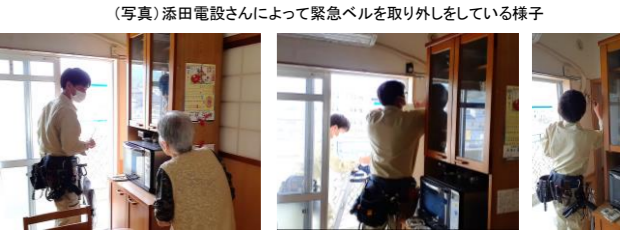
(写真) 添田電設さんによって緊急ベルを取り外しをしている様子 共同募金会 添田町支会 ☎ 82-2600
